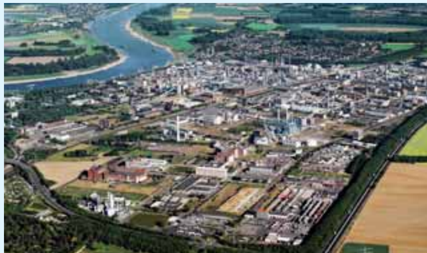
Im Chempark Dormagen investiert Bayer CropScience in den nächsten zwei Jahren rund 30 Millionen Euro in den Ausbau der Produktionskapazität des Wirkstoffs Prothioconazole.
